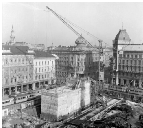
A 2-es metró építése a Blaha Lujza térenél.
