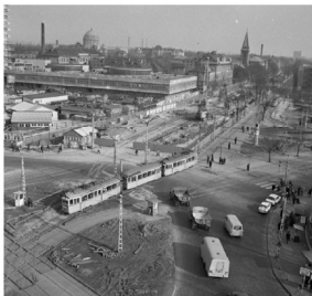
A 3-as metró építése a Nagyvárud térenél.
